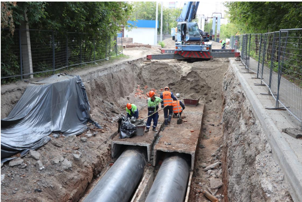
Реконструкция магистрального трубопровода в Индустриальном районе г. Перми
